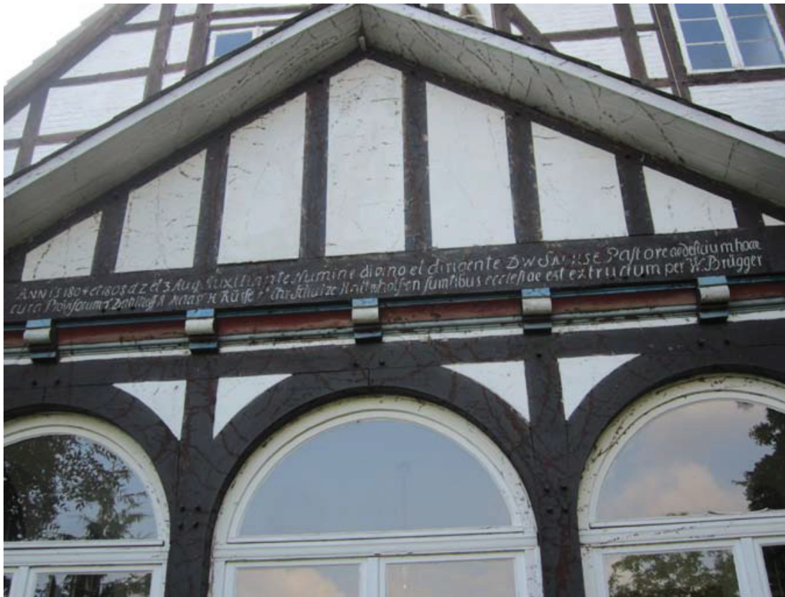
Abb. 3: Deelenbalken mit Inschrift an der Ostwand des Pastorats. Foto: Verf.
